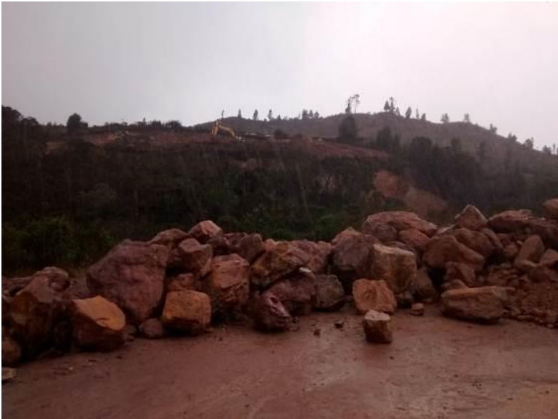
Obras de pavimentación vía Duitama-Charalá (predios de propiedad de la administración municipal) -Duitama (febrero 2015)
