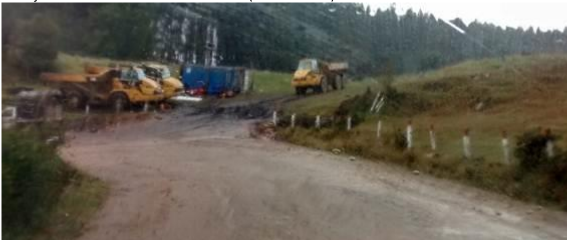
Obras de pavimentación vía Duitama-Charalá (predios de propiedad de la administración municipal) -Duitama (febrero 2015)
