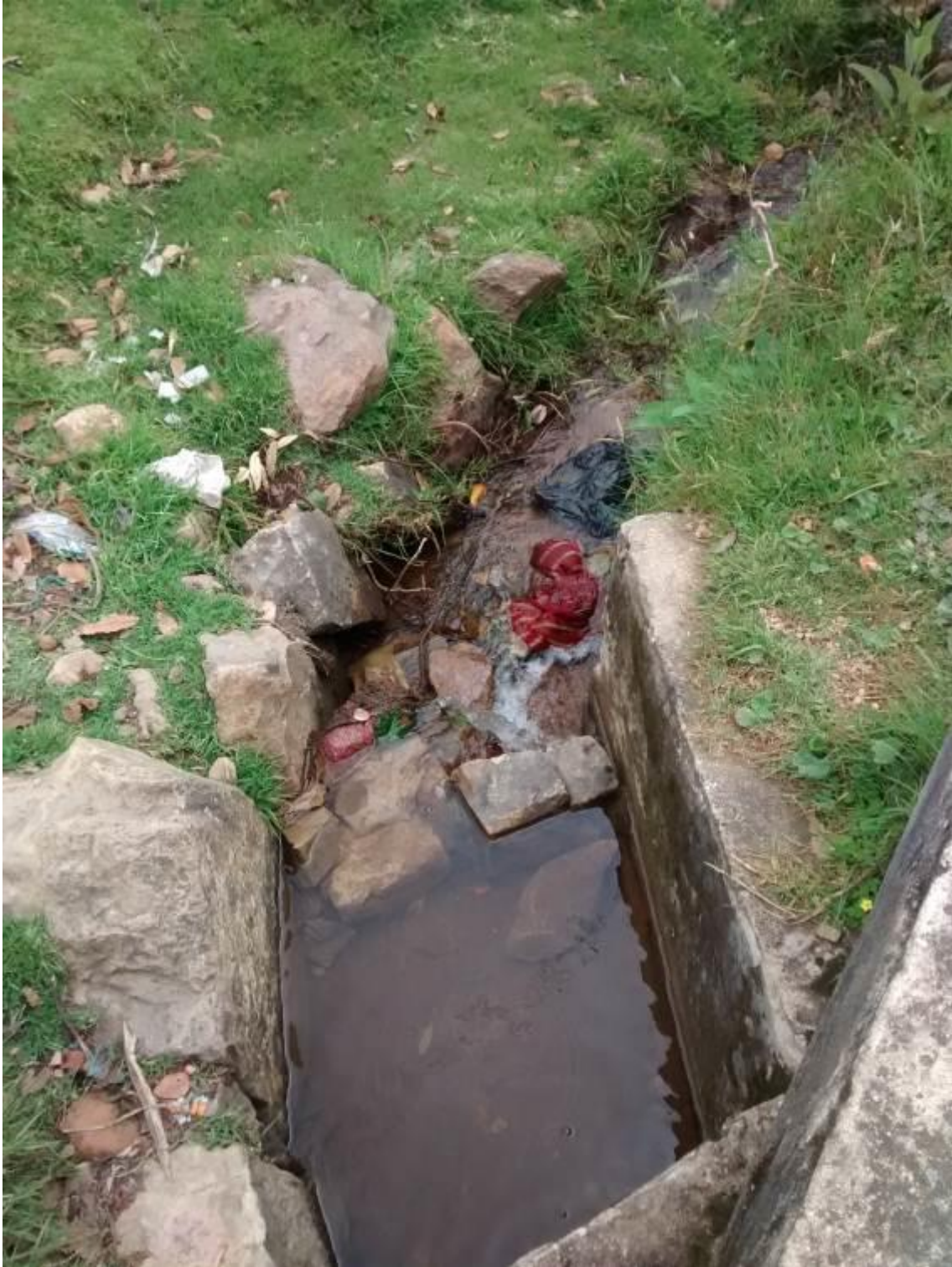
Canalización aguas. Vereda Avendaños 1 –Duitama (febrero 2015)
