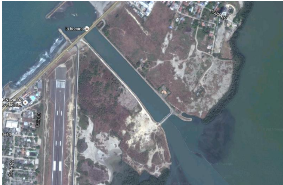
Figura 6 Compuertas de La Bocana, Google Maps, 2015.
