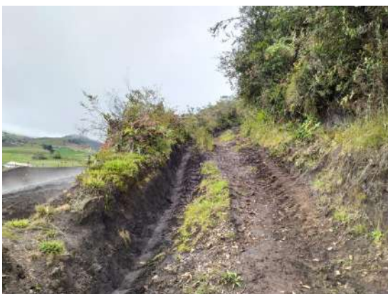
Apertura de vías – uso inadecuado
