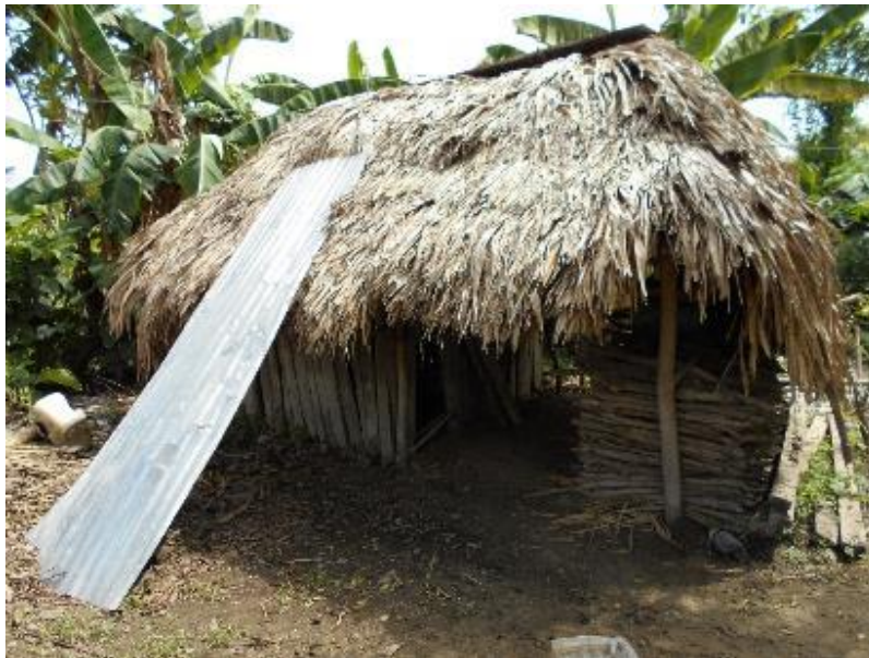
Foto 6. Vivienda tradicional con techo de palma amarga y teja de zinc
