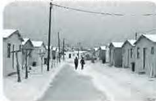
Viviendas del Programa de Renovación Urbana
