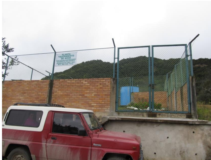
Fotografía 3 Planta de tratamiento del Acueducto Quebraditas. Fotografía: Camilo Rodríguez, octubre de 2013
