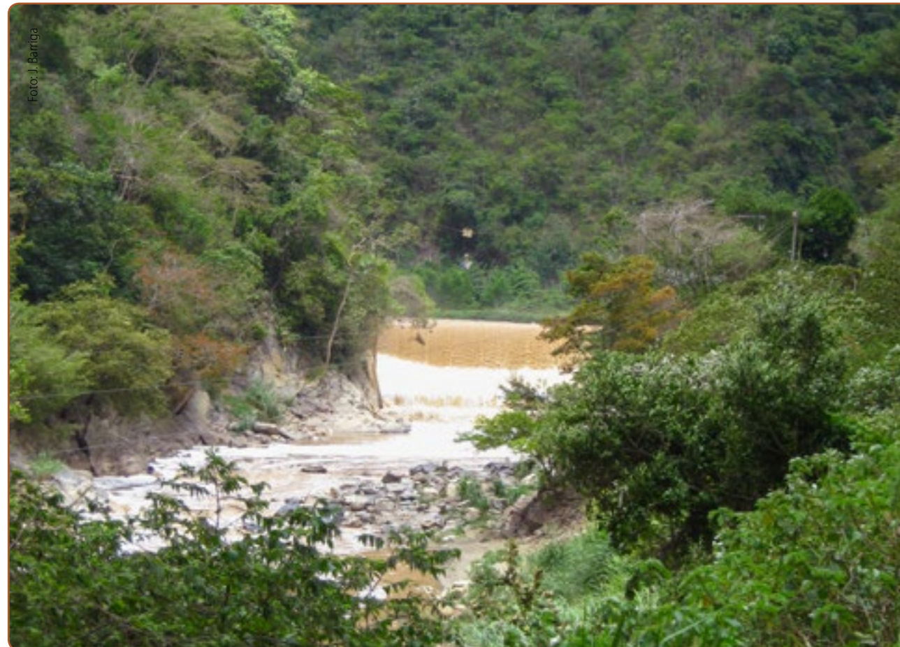
Foto 3.1. Represa para hidroeléctrica en el río Negro.
