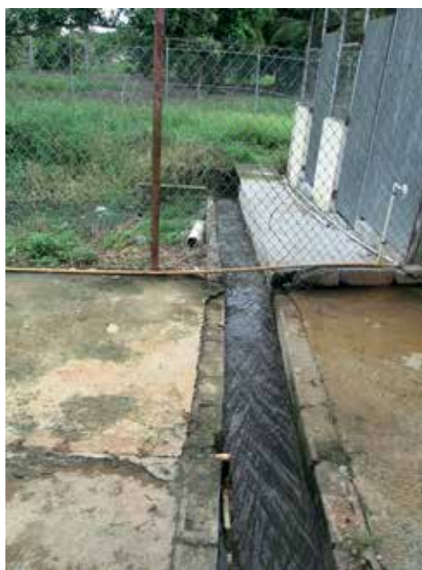
Figura 6. Canal desagüe aguas negras de una empresa pecuaria., Fotos: C. A. Lasso.
