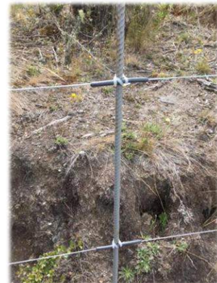
Foto 21. Cerca eléctrica sostenida por varillas de hierro de 5/8 de pulgada.
