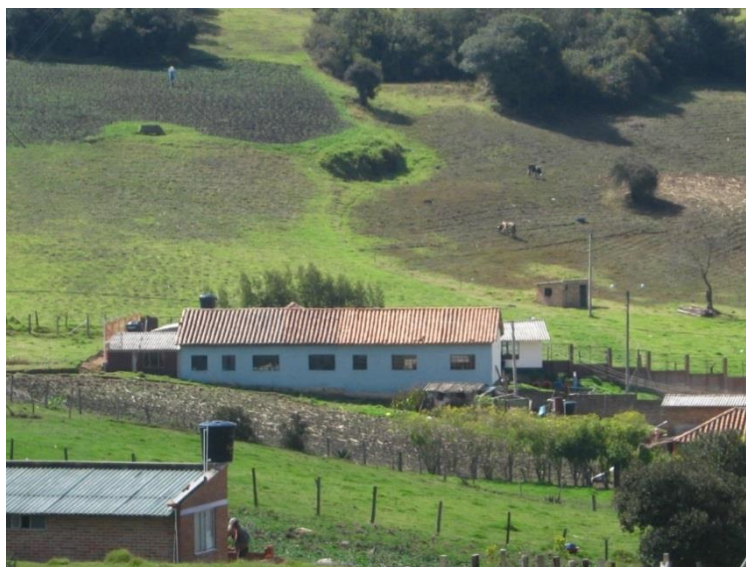
Figura 15. Escuela de la vereda Los Medios. Fotografía: Javier Barriga
